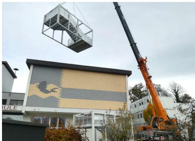
Die Stiegenhäuser wurden komplett fertig geliefert und mit dem Kran vom LKW gehoben.
