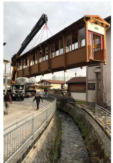
Die überdachte Verbindung zum Turnsaal wird aus der Verankerung gehoben.
