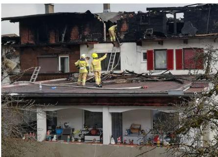
Nach dem Entfernen des Blechdachs mussten die einzelnen Glutnester mittels Wärmebildkamera lokalisiert und gelöscht werden.
