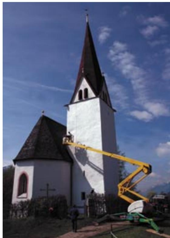
Nach dem Reinigen der Fassade durch einen Dampfstrahler bekam die Kirche einen neuen Anstrich.
