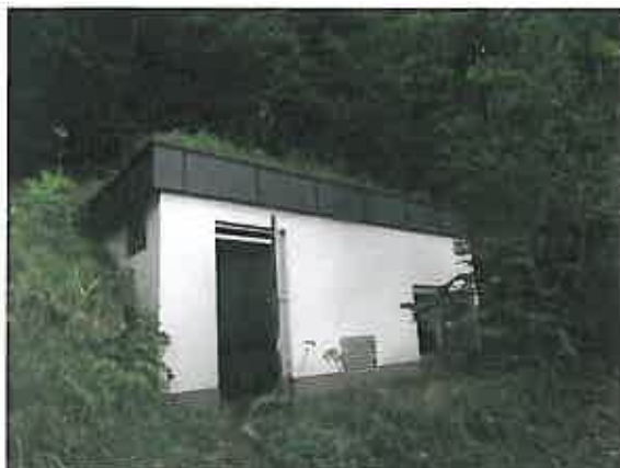
Foto 1 - Hochbehälter Eulenstein (Foto: Martin Baldes, 2014:09.11 11:42:51)
