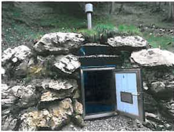
Foto 3 - Quellstube der Oberen Thalerquelle (Foto: Martin Baldes, 2014 09:11 12 37 49)
