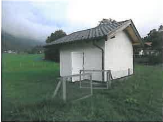
Foto 1 - Pumpenhäus Tiefbrunnen Schusterwinkel (Foto: Martin Baldes, 2014:09:11 09:40:18)
