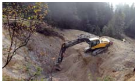
Aushub für den Hochbehälter
