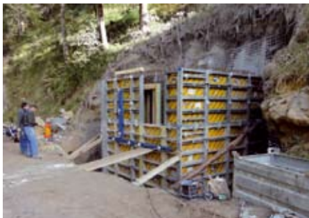
Bau der Druckerhöhungsanlage
